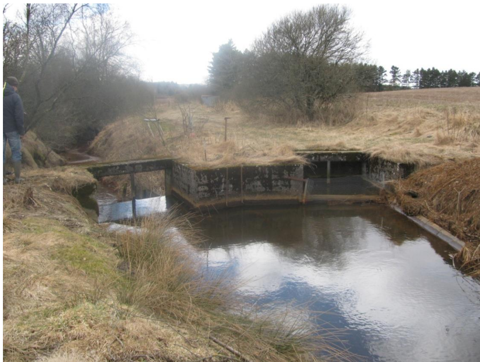
Figur 2.3.2: Stemmeværket ved Brogård Dambrug i Brogård Bæks st. 292 set fra opstrøms side. Til højre i billedet ses indløbsbygværket til dambrugets fødekanal, som forløber langs træærken i baggrunden. Til venstre ses selve stemmeværket. Foto 12. marts 2013.
