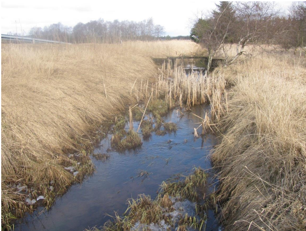
Figur 3.2.2: Den eksisterende afløbskanal på strækningen nær udløbet i Karstoft Å. Til venstre forløber Sønder Ommevej, og mellem vejen og kanalen ligger en jordvold, antageligt stammende fra gravning af kanalen.
