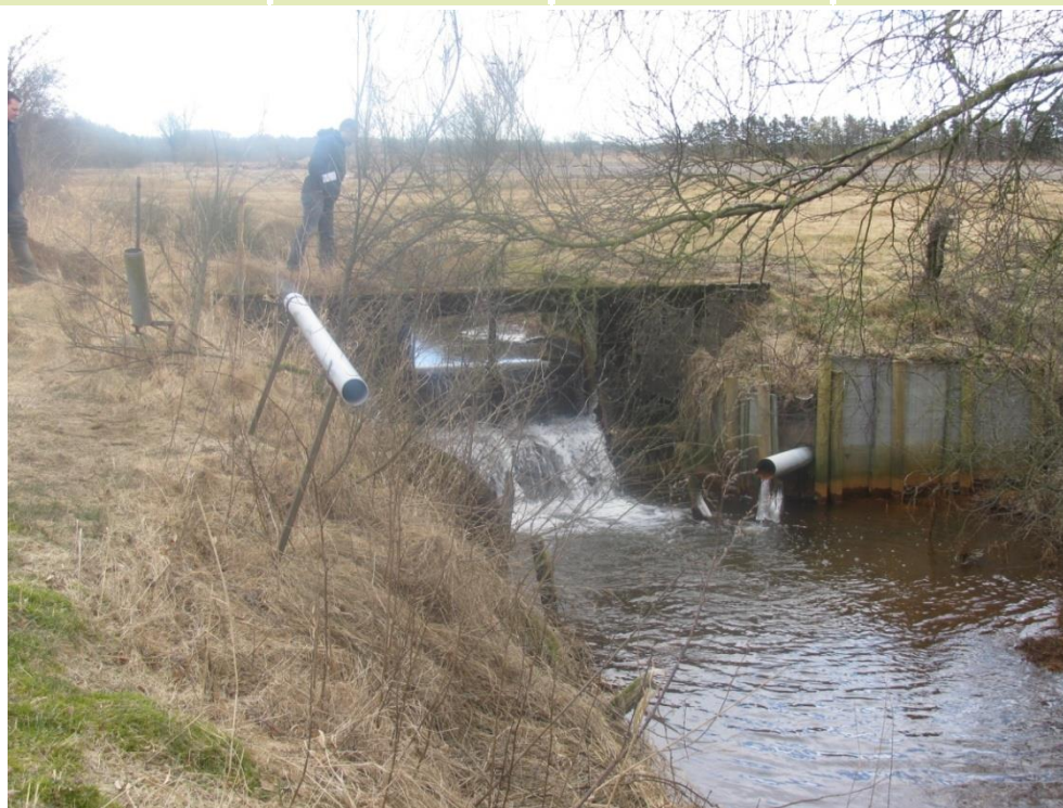
Figur 2.3.1: Stemmeværket ved Brogård Dambrug i Brogård Bæks st. 292 set fra nedstrøms side. Til højre i billedet anes dræntilløb samt det åbne okkerbelastede grøftetilløb i vandløbets st. 287 Foto 12. marts 2013.
