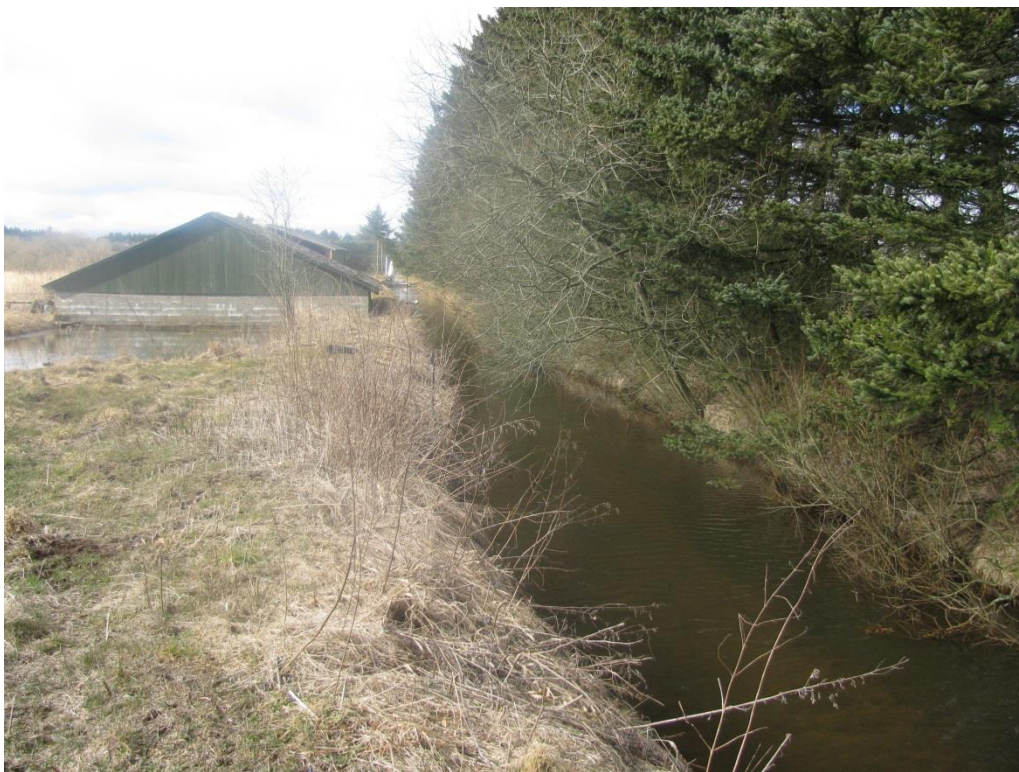
Figur 2.10.1: Bygning (formodentligt et klækkehus) beliggende ved fødekanalen ca. 150 m nedstrøms stemmeværket.
