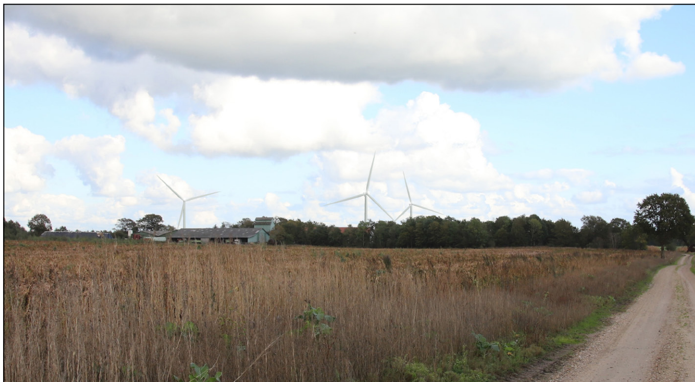
Figur 6.6 Visualisering (fra fotopunkt nr. 15 i miljøkonsekvensrapporten) af de tre vindmøller iaf de tre vindmøller inden for lokalplanområdet set fra Hallundbækvej nord. Afstanden til nærmeste planlagte vindmølle er ca.1,7 kilometer. Intensiteten af den visuelle påvirkning: Moderat. Opleves vindmøllerne som et sammenhængende anlæg: Ja. Opstillingsmønster: Opfatteligt. Vurdering af den visuelle påvirkning: Mindre negativ.
