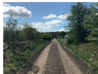
Grusvejen asfalteres og udvides og vil fremover udgøre stamvejen til området. På arealet, hvor gården ligger i dag, opføres området's fælleshus.
