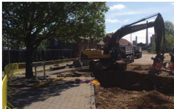
Fra renoveringen af I fase i 2017
