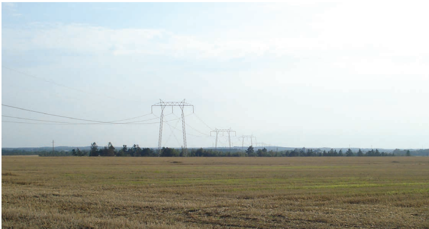
Højspændingsledningen bevæger på synlig vis igennem landskabet. Her set fra Bording Bakkeø med Nørlund Plantage i baggrunden.
