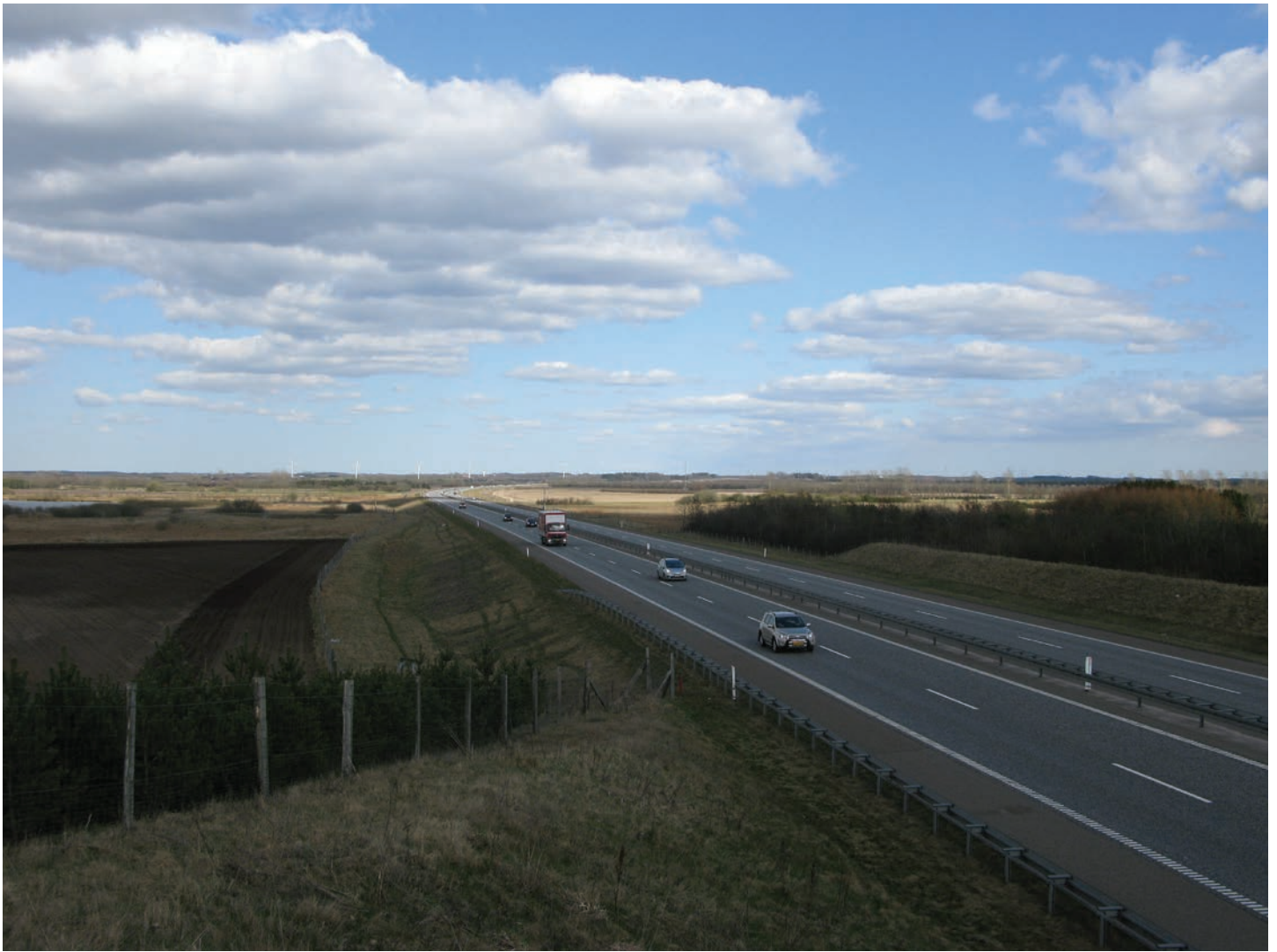
Motorvejsdæmningen over Storådalens ligger meget synligt i det åbne landskab.
