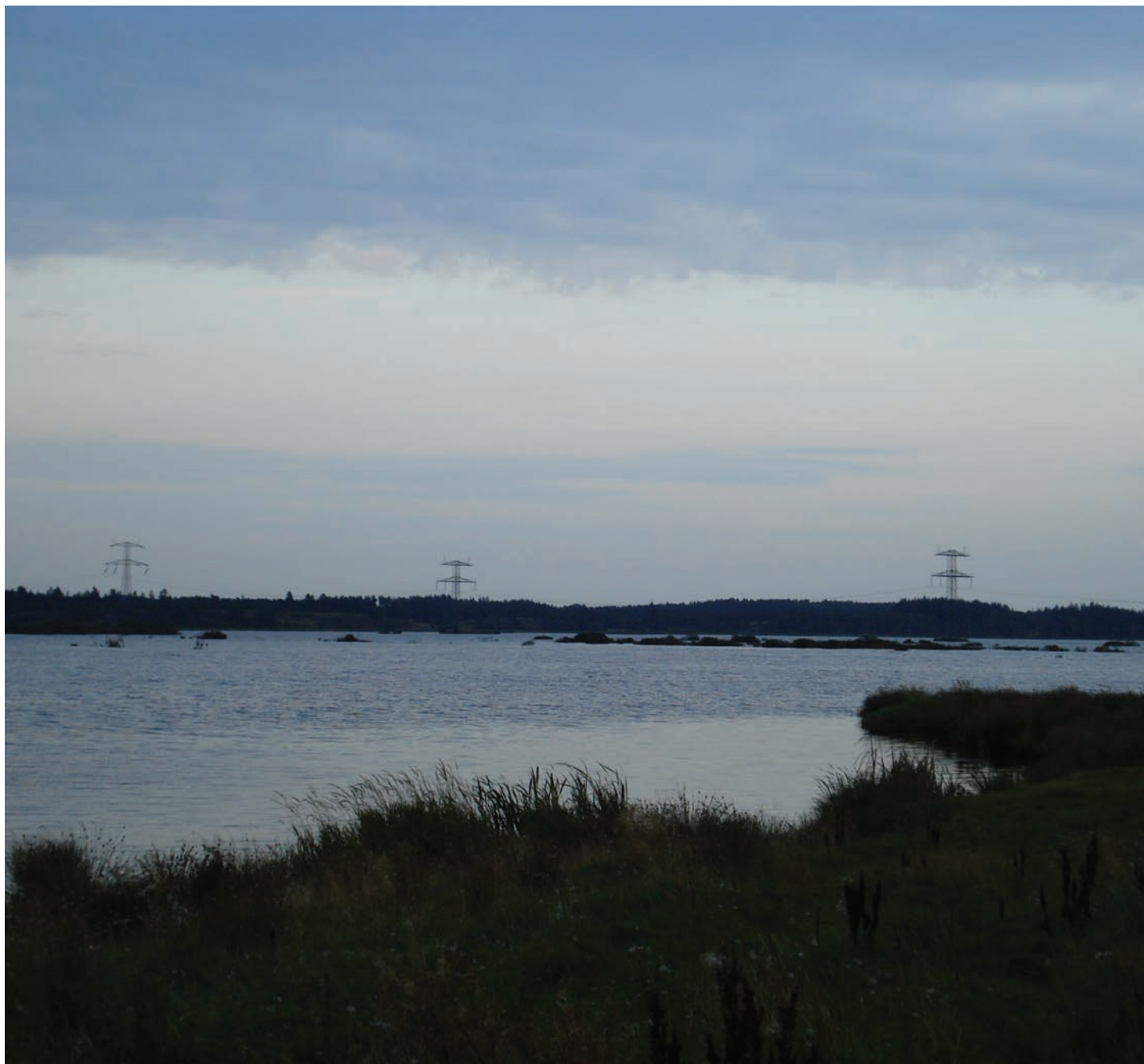
Højspændingsledningens master der idag er placeret midt i den genoprettede Bølling Sø, men er under proces for at blive flyttet.
