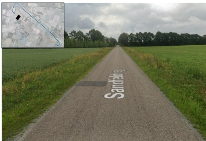
Figur 14-5. Udformning af Sandfeldvej (vejstrækning langs ledningstracé). Billede taget i sydgående retning. (Kilde: Google Maps, 2023).
