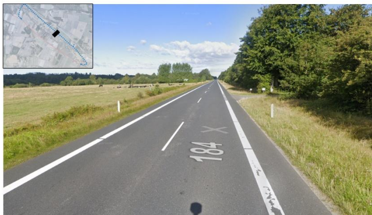
Figur 14-2. Udformning af Herningvej - nordvestlig delstrækning. Billede taget i nordvest gående retning. (Kilde: Google Maps, 2022).
