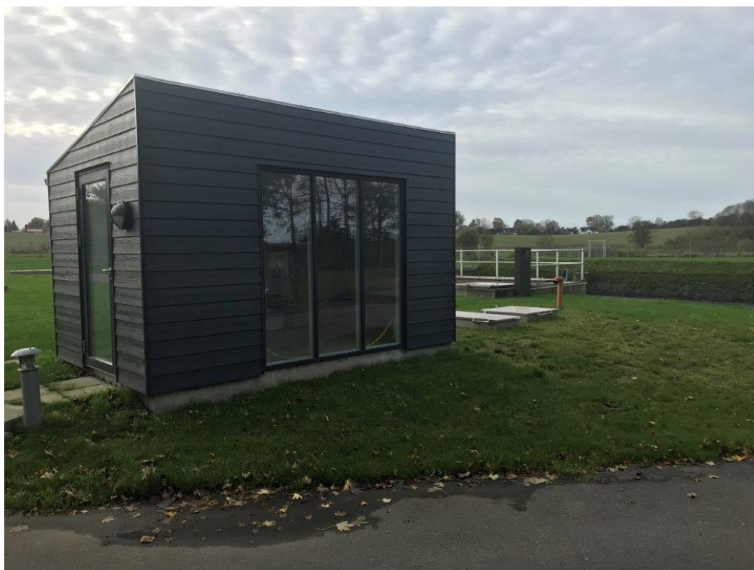
Figur 2-8: Eksempel på en pumpebygning.
