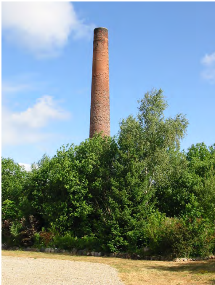
Skorsten på det gamle teglværk
