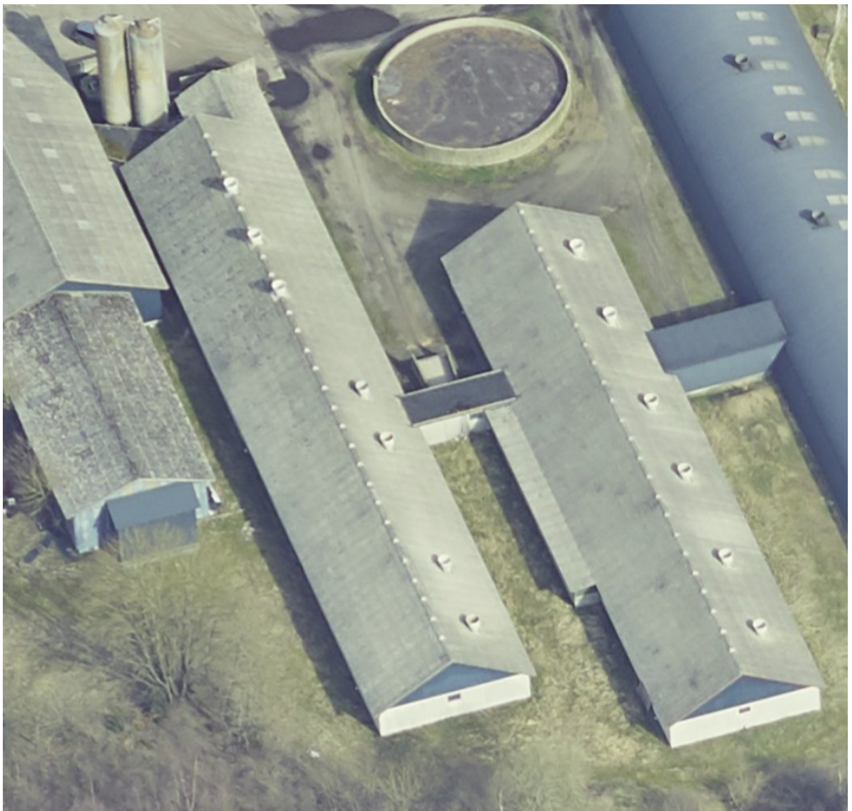
Figur 6 – eksisterende bygninger (1 til 5).
