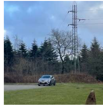
Eksisterende højspændingsledning i det nordvestlige udkant af området
