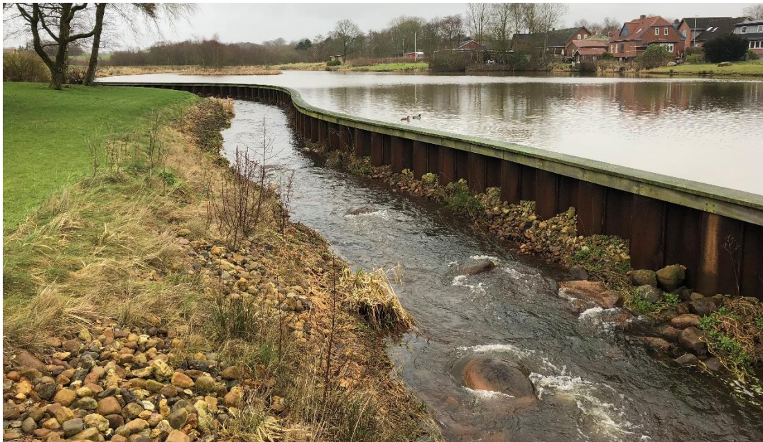
Figur 5-3. Spunsen ved Rækker Mølle (Foto: Per Søby, Ringkøbing-Skjern Kommune).
