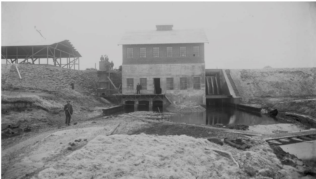
Figur 3-1. Turbinebygning og stemmeværk i den vestlige ende af MES Sø ved etableringen i 1918 (Foto fra Arkiv.dk).
