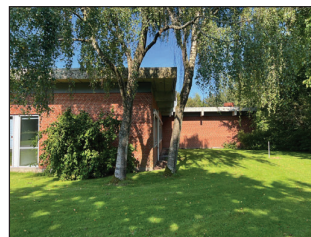
Birketræer tæt på administrationsbygningen mod øst.
