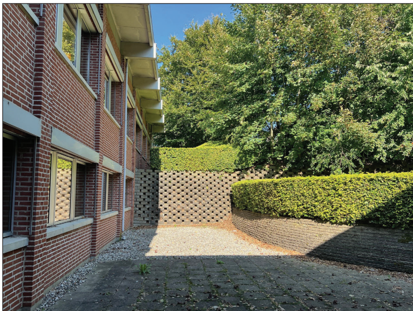
Del af terrasseanlægget som optager terrænspringet. Foto af den øst vendte længe med "skoven" oppe på terrassen.
