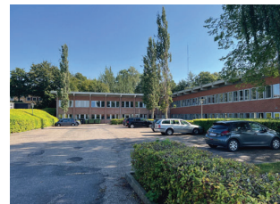
Den eksisterende administrationsbygningens nordfacade.
