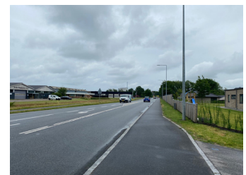
Herningvej set mod øst og Brande by
