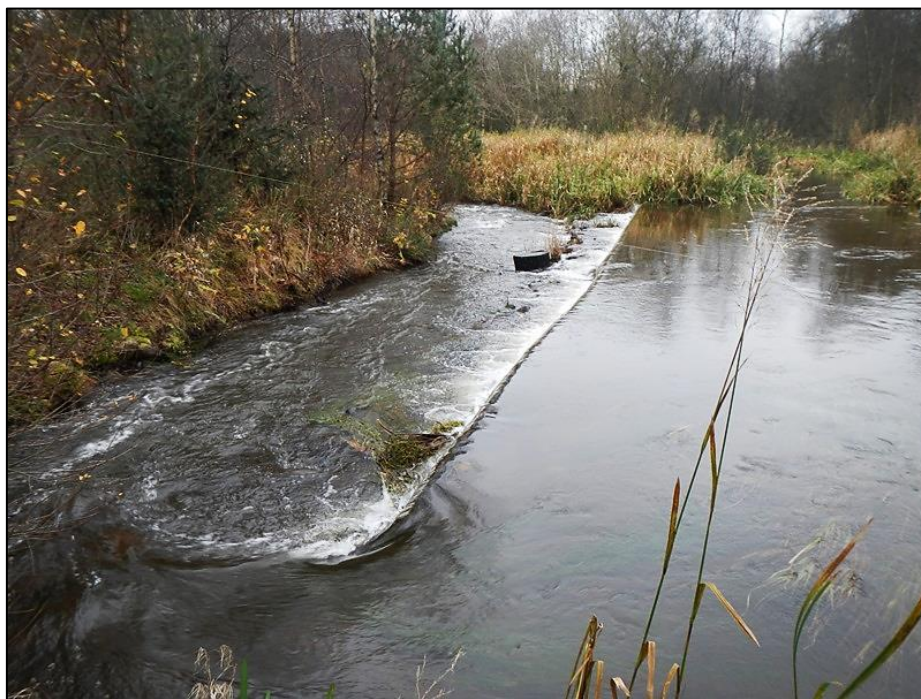
Forsidefoto: Indløbet af omløbsstryget, med overløbskant, opstrøms Harrildgård Dambrug.
