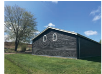
Nabobygning sydvest for lokalplanområdet
