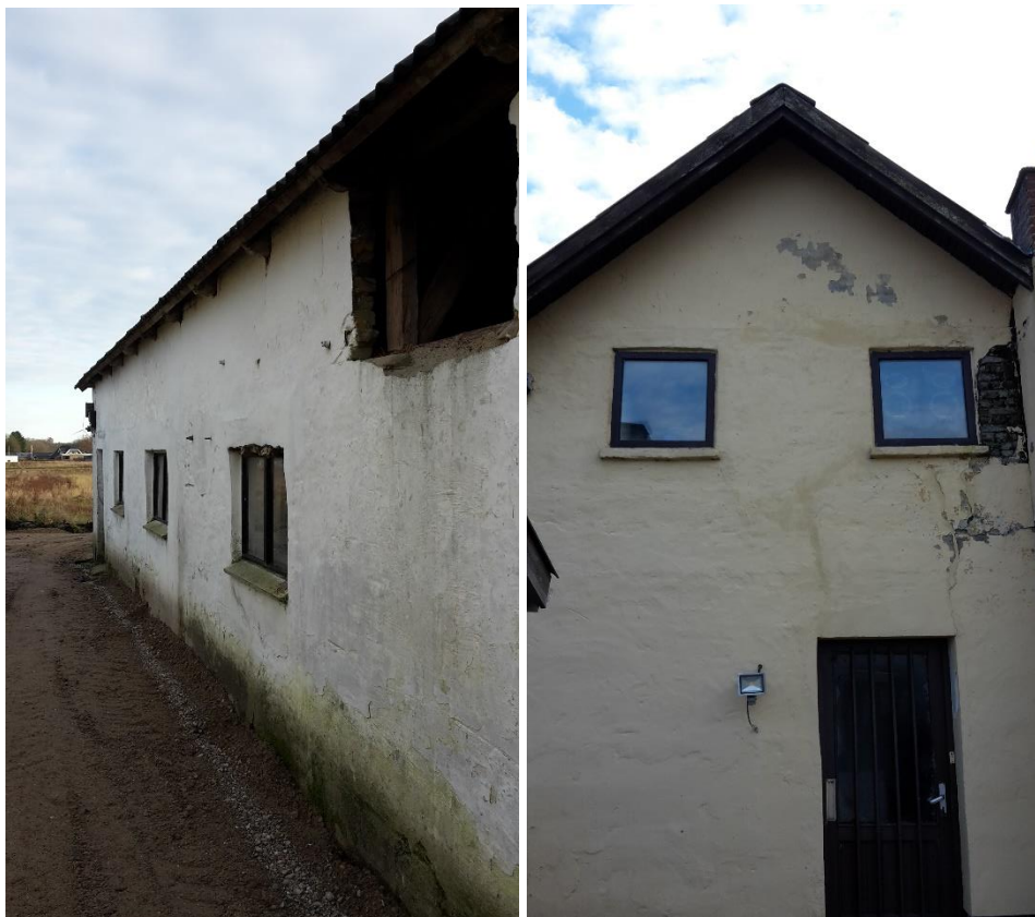
Figur 1.6 T.v. den vestlige side af stalden med åben loftsluge som giver adgang til loftsrummet og t.h. vestlige gavl på stuehuset med forvitret puds dog uden tydelig adgang for flagermus.
