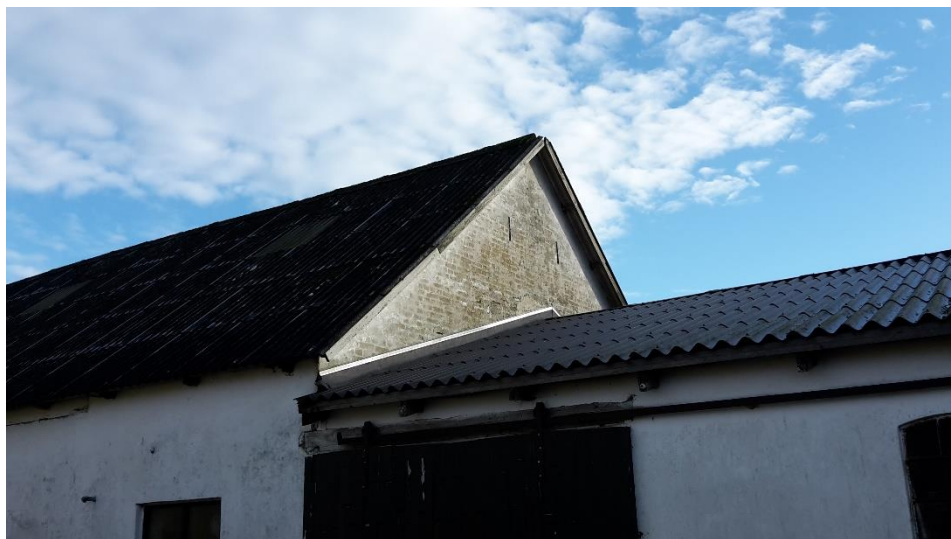
Figur 1.4: Stalden set fra syd-vest. Tagkonstruktionen tillader tydelig adgang ind under taget.
