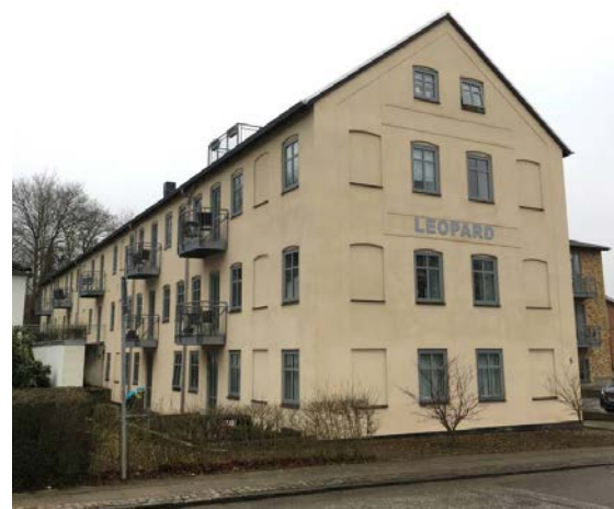
Den typisk fabriksgavl, Tulstrupvej 5
