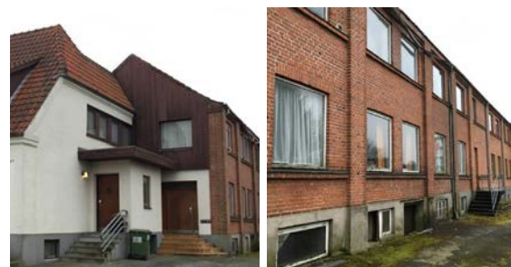
Større baghusfabrik, Villavej 27
