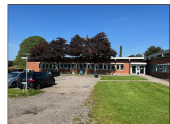
Blodbøg langs facaden ved hovedindgangen.
