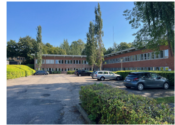
Den eksisterende administrationsbygning nordfacade.
