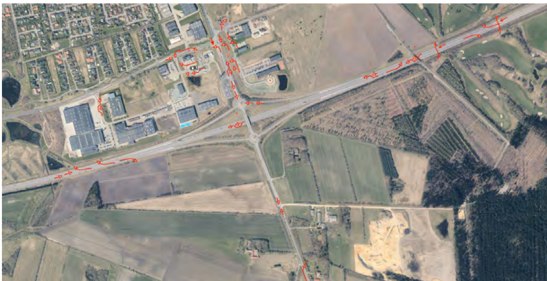
Figur 4.8: Registrerede uheld omkring tilslutningsanlægget inden for de seneste 5 år. COWI
