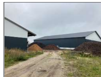
Eksempel på oplag ved virksomhedens haller - øst for lokalplanområdet
