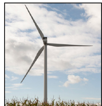
Figur 10 . Typisk dansk vindmølle design med lukket rørtårn, møllehus og tre vinder.
