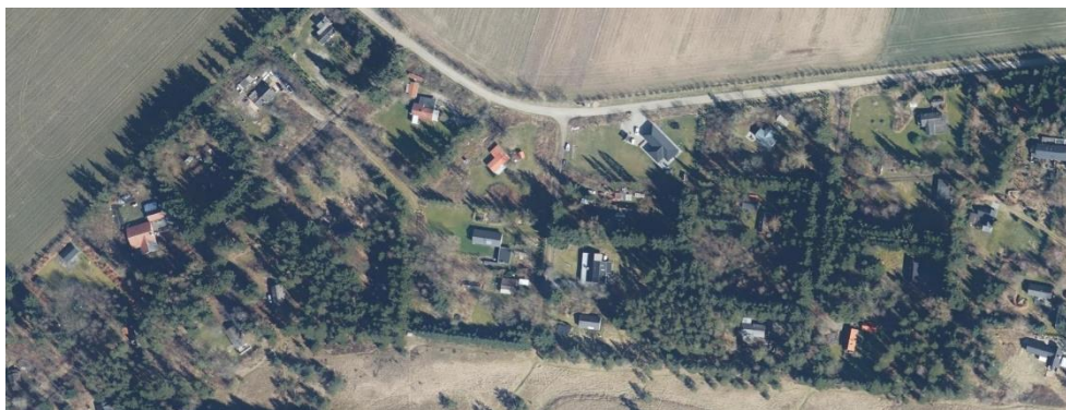
Figur 5-20 Luftfoto (SCALGO) af en del af det eksisterende sommerhusområde.
