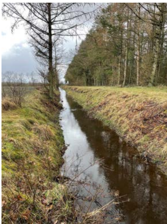
Figur 3-11 Ruskjær Grøft ligger langs den nordlige områdegrænse. Billedet er taget fra øst mod vest.
